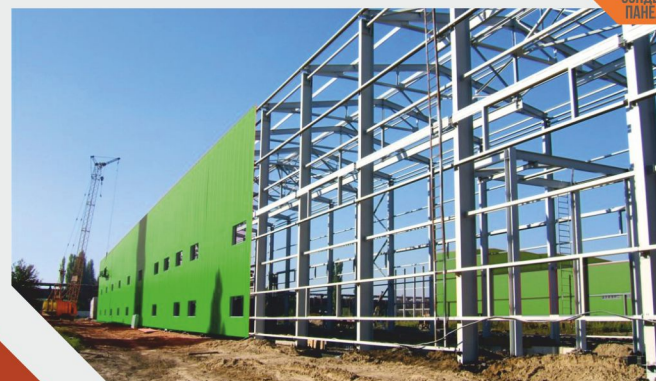
Строительство быстровозводимых зданий на основе металлокаркаса и сэндвич панелей
