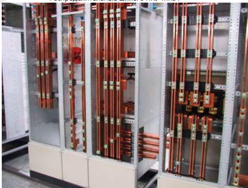
Распределительные шины в НКУ типа Р
