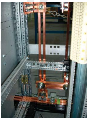
Заземляющая шина в НКУ типа Р
